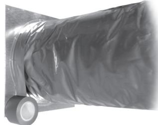
8. Montera kondensisoleringen mot anslutningsplåten på samma sätt som på undersidan. Se punkt 4 och 5.
