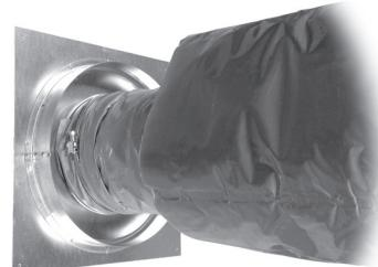
4. Skjut in kondensisoleringen mellan den yttre och inre stosen. Träd plaststrumpan utanpå den yttre stosen. Lämna c:a 1 cm mellan plaststrumpans kant och plåten, så att tejpen kan fästa mot stosen.
